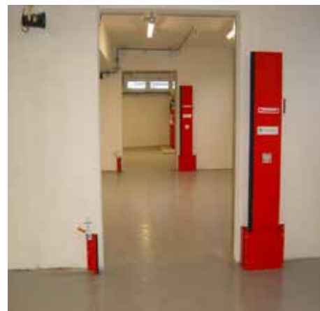
Manuelle Barriere vertikal drehbar
