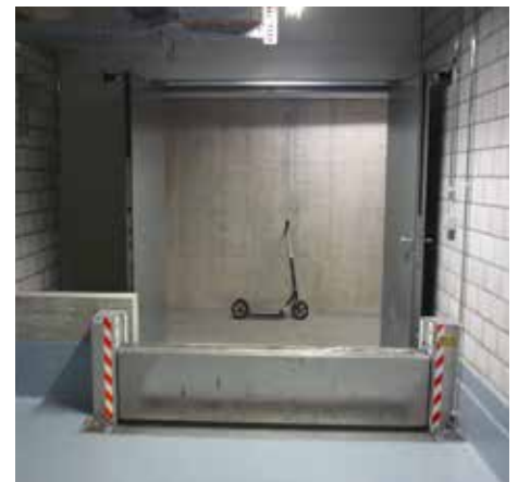
Gefahrengutlager Briefzentrum Mülligen, Schlieren
