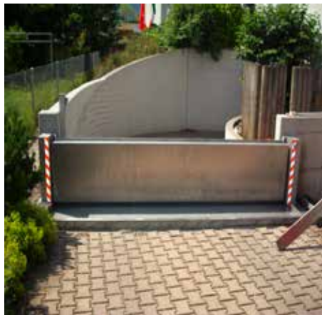
Tiefgaragen-Klappschott MFH Mühleliweg, Tuggen
