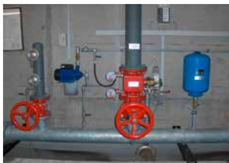
Aarepark Würenlingen Quelle: JOMOS, Balsthal
