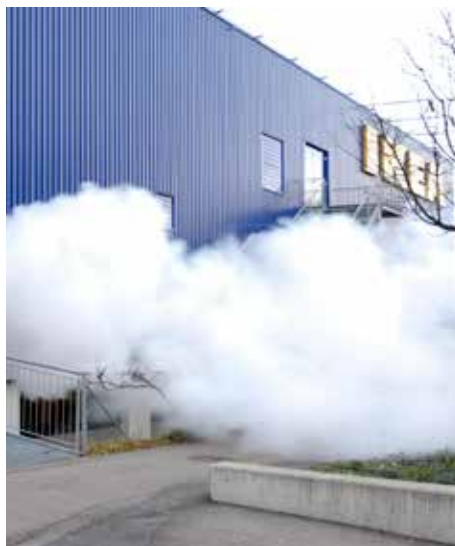
Grossgebäude- und Tunnelvernebelung zur Visualisierung und Prüfung der Entrauchung
