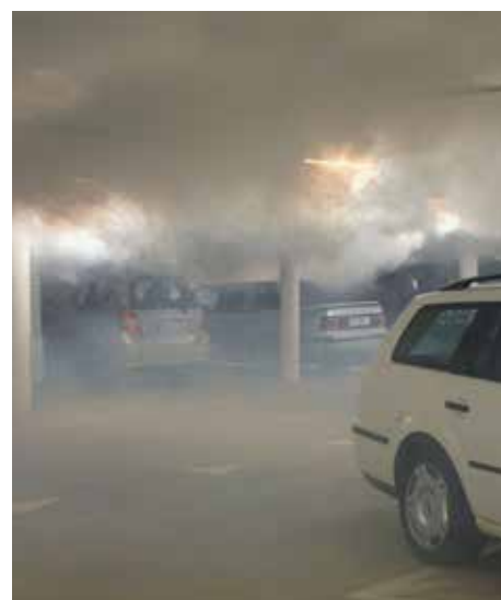
Testen der Rauchabzugsanlage
