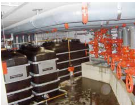
Nasssprinkleranlage mit Frostschutz Quelle: JOMOS Balsthal
