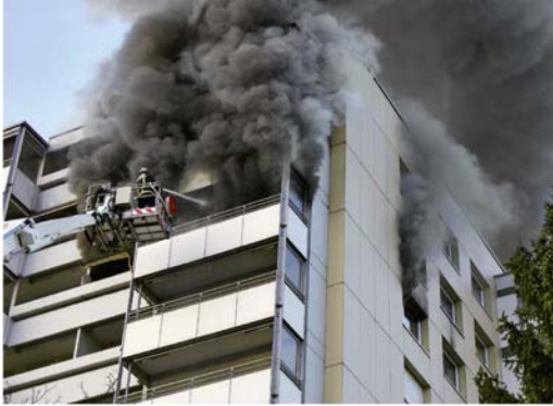
Foto: Hanny Dorer Durch das überdruckbelüftete Treppenhaus konnten Einsatzkräfte bis zum Brandherd vordringen.
