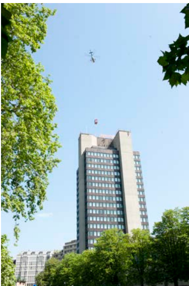
Foto: JOMOS Sanierung Marriott Hotel, Zürich 2011
