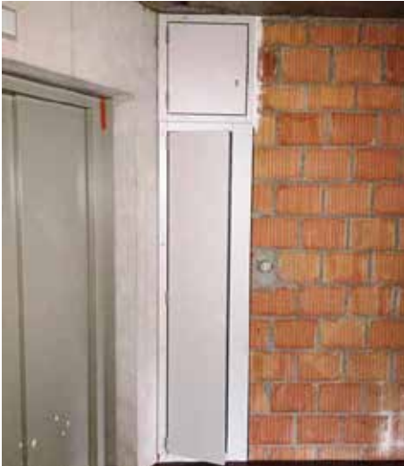
Einbau der Entrauchungsklappe während der Bauphase
