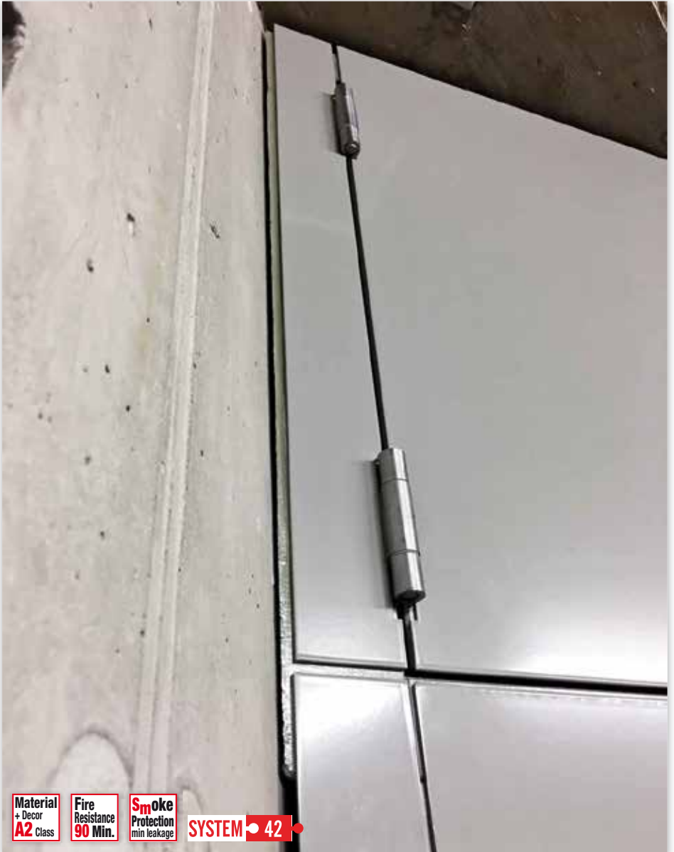
Detailbild Revisionsür PRI000R ETX, kundenseitig aufgebrachte Edelstahloberfläche
